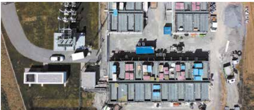
Innovatives Baukonzept: Aus Platzgründen kommen die Wechselrichter auf das Dach.
