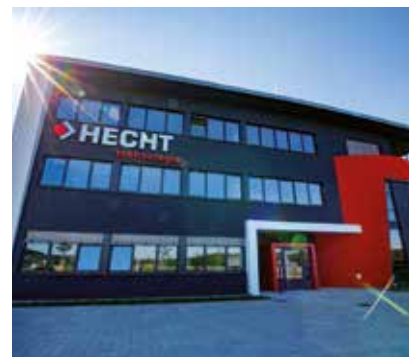
Technisches Service Center
